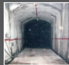
D'ici la fin du T3, la double rampe du développement souterrain de Yalea a atteint la distance de 460m et se trouve à une profondeur verticale de 86m.
