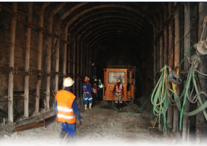
Développement souterrain de Yalea: installation des étais de la rampe.
