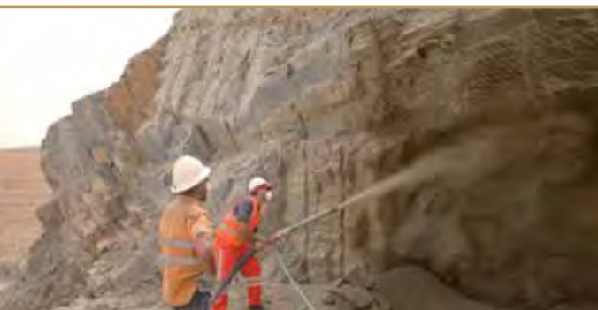
Gunitage de l'entrée du nouveau tunnel souterrain de Gara.
